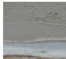
Dämmung der Gauben mit Aerogel
