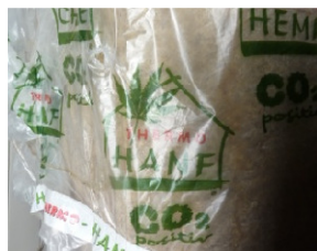
Dämmung des Daches mit Hanf und Holzfaserplatten
