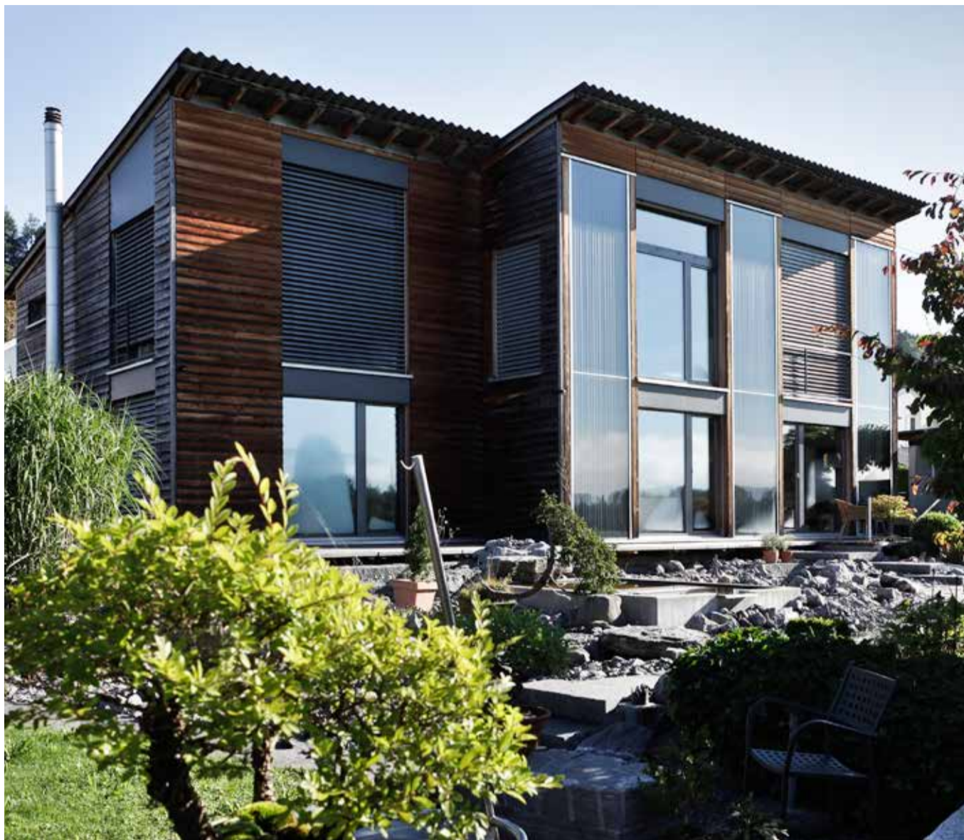
Fassadenintegrierte thermische Solaranlage an einem Einfamilienhaus in Gams.
