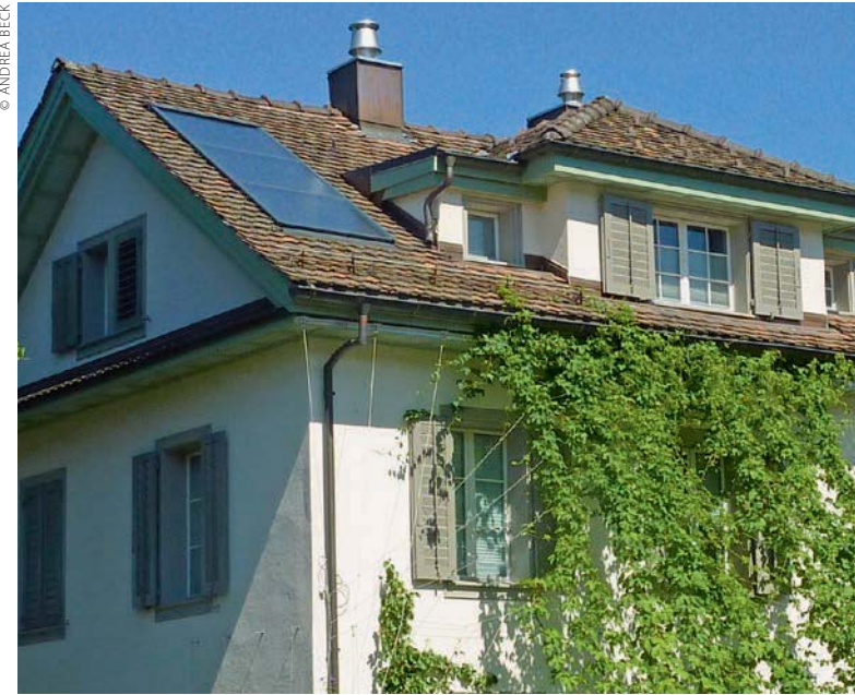
Solarbau 4: Auf Mass gefertigte thermische Solaranlage (zwei gleiche Anlagenteile links und rechts der Lukarne)
