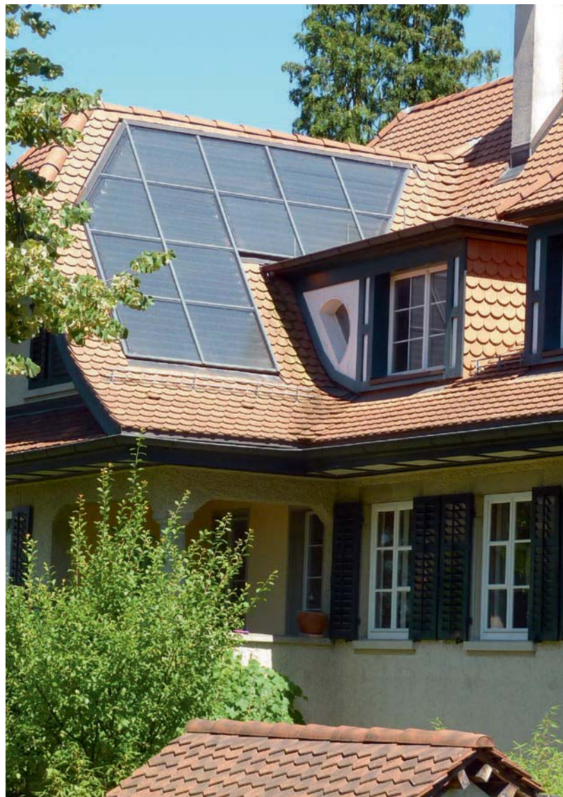
Solarbau 3: Auf Mass gefertigte thermische Solaranlage
